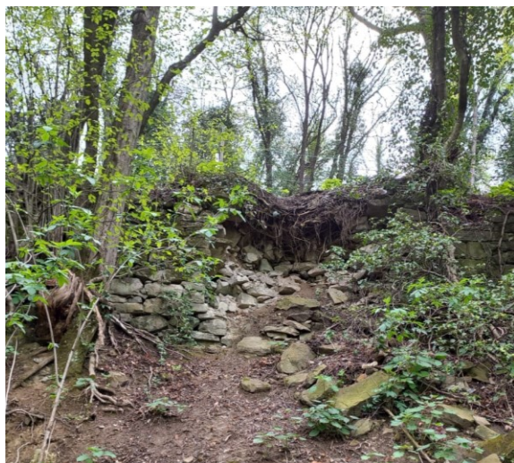
Fig. 2: Via Commerciale dopo civico 180 – Muro di sostegno del corpo stradale.
