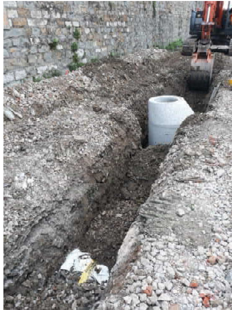
Figura 4 - Esempio di sedime che caratterizza l'area portuale in un settore adiacente a quello della trasformazione: immediata è la lettura visiva della permeabilità alta favorita da granulometrie grossolane proprie del sedime ferroviario
