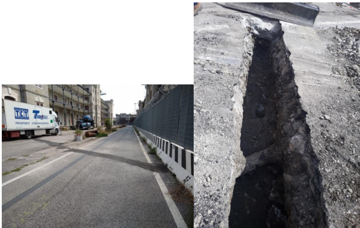
Fig. 8.1 – scavo di assaggio presso l'area antistante il Magazzino 26
