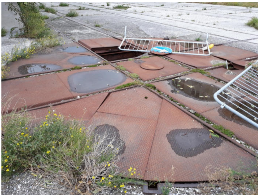
Fig.9.3 – Esempio di piattaforma girevole ancora visibile tra il magazzino 15 e il magazzino 18
