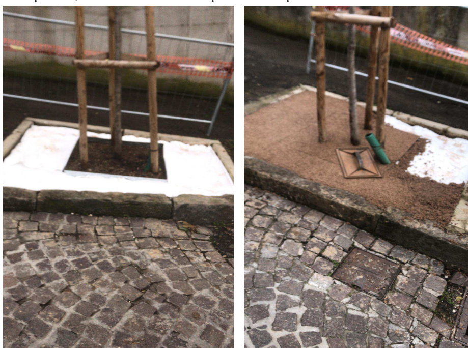
Operazioni di messa in opera di pavimentazione in conglomerato drenante per formazione di contorno albero e costituzione riquadro centrale
