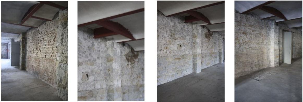
Figura 21_ Particolare delle voltine Monier esistenti, già interrotte in corrispondenza dell'incontro con le pareti portanti, in cui si prevede di inserire i fancoil a pavimento, appositamente schermati, a servizio delle sale poste al livello superiore.
