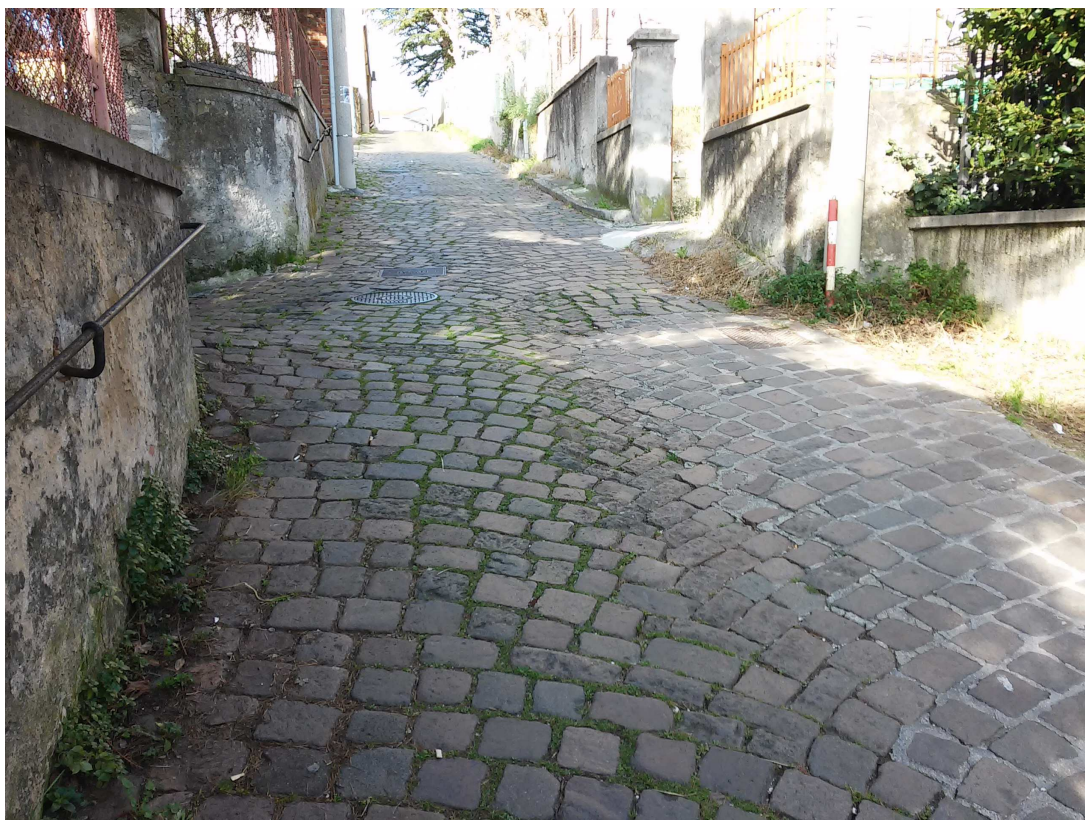
foto 3: Via Zara tratto superiore sconnesso e ammalorato
