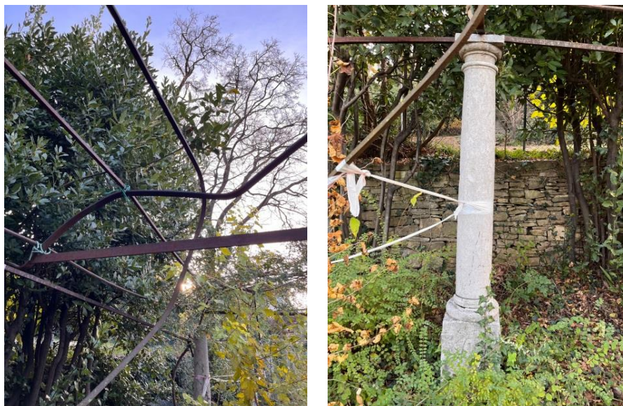
Cedimenti e deformazioni dovuti alla caduta di un albero e alle tensioni provate dalle colonne instabili
