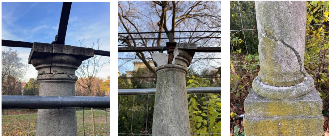
Colonna 09.b – Frattura del capitello; parziale mancanza del capitello; frattura del fusto alla base
