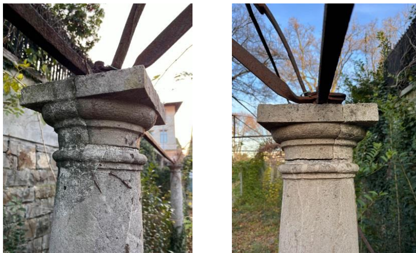
Colonna 13.a – Distacco e perdita di parte del capitello e del fusto in sommità; elemento incongruo – capitello e fusto ricostruiti con malta cementizia
