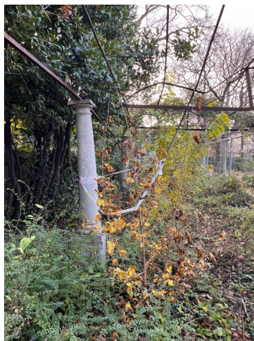
Cedimento delle fondazioni con successiva perdita di stabilità
