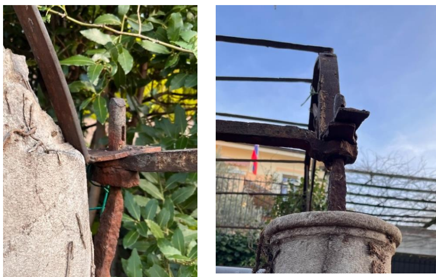
Perdita di alcuni cunei di fissaggio; ossidazione
