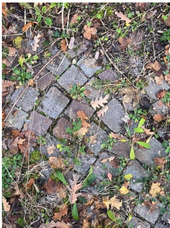
Stato di conservazione pavimentazione in cubetti di porfido con posa "a coda di pavone"
